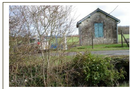
À proximité de Palud, la station de pompage d'Aulnay, construite en 1938
